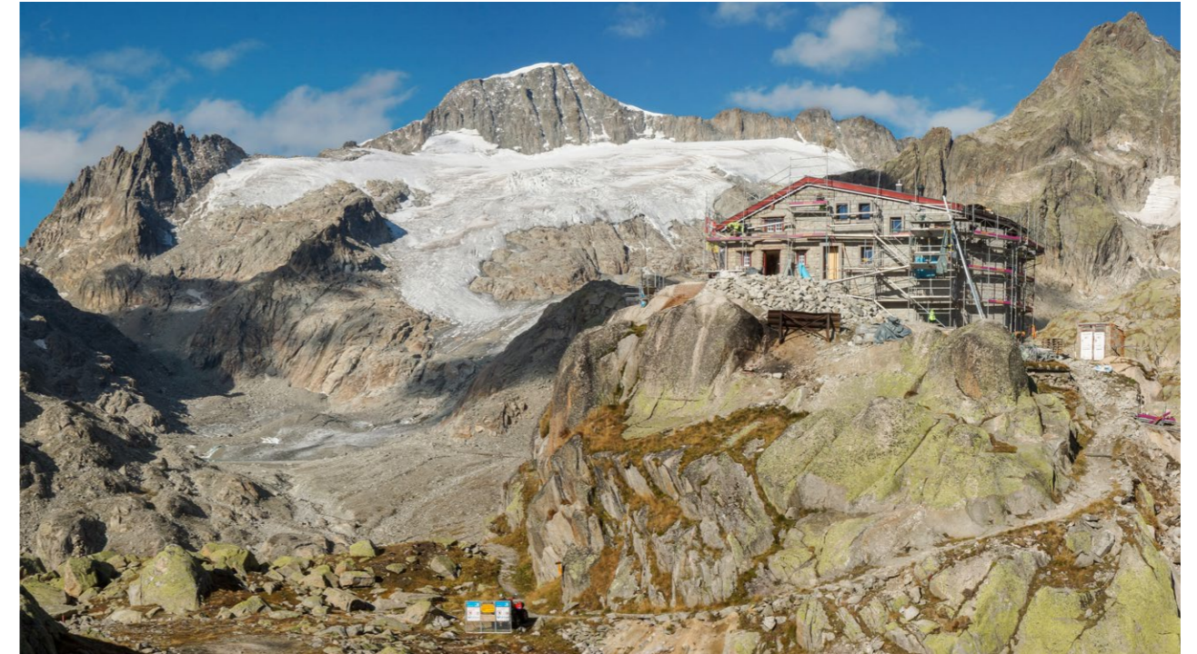
Die bestehende Natursteinfassade der Albert-Heim-Hütte SAC wurde etwas verlängert, das zusätzliche Volumen fällt von aussen kaum auf. © George Eisler
