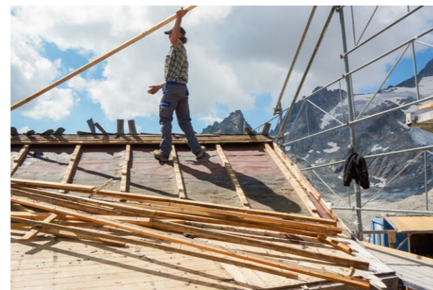
2542 m ü. normaler Baustelle: Es wurde mit Hochdruck am Umbau der Albert-Heim-Hütte SAC gearbeitet, denn die schneefreie Zeit im Gebirge ist kurz. © George Eisler
