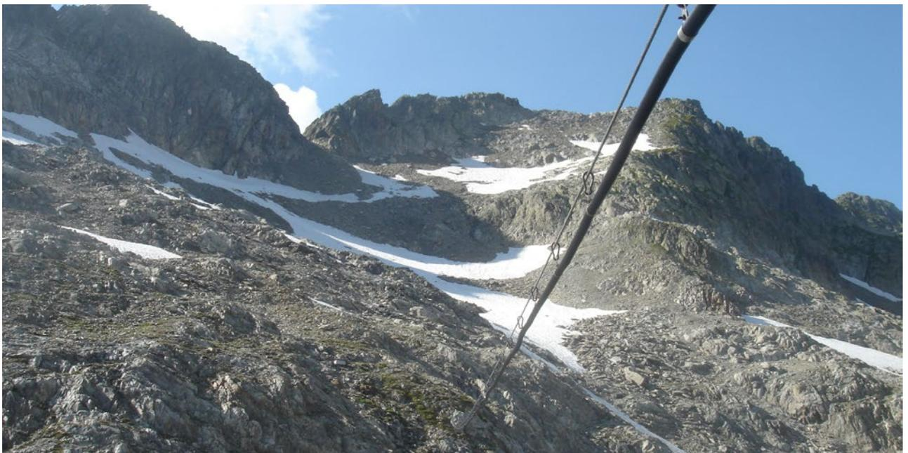
Un tuyau suspendu dans les airs permet d'approvisionner la Camona da Cavardiras CAS avec l'eau d'un névé.
