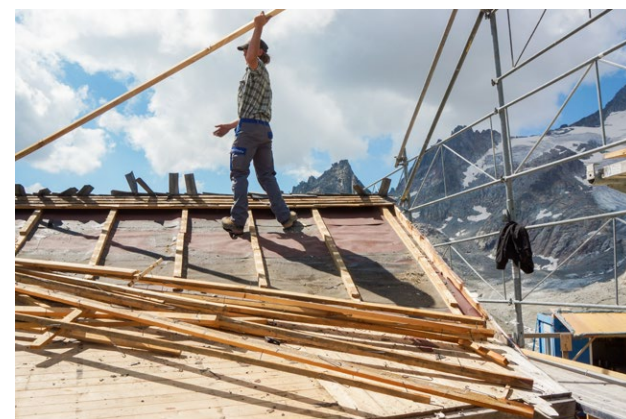
2542 m au-dessus d'un chantier normal : travaux de transformation de l'Albert-Heim-Hütte SAC sous haute pression en raison de la brièveté de l'absence de neige en montagne. © George Eisler
