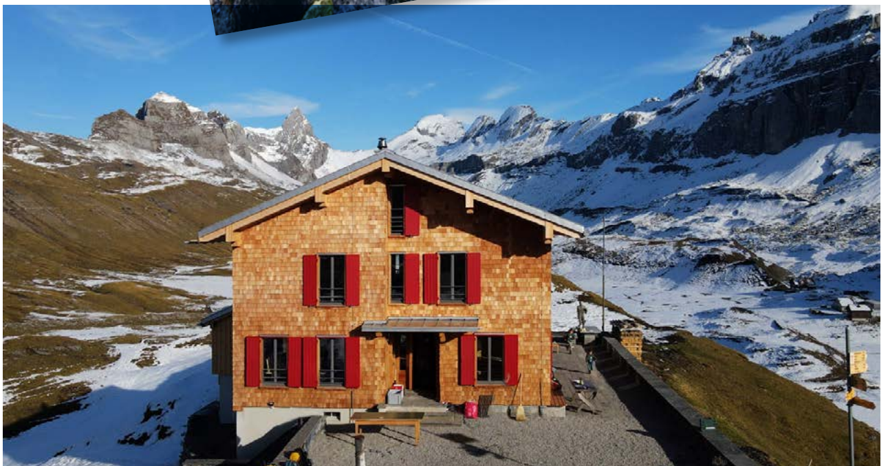
La Glattalalpütte SAC après d'importants travaux de rénovation.
