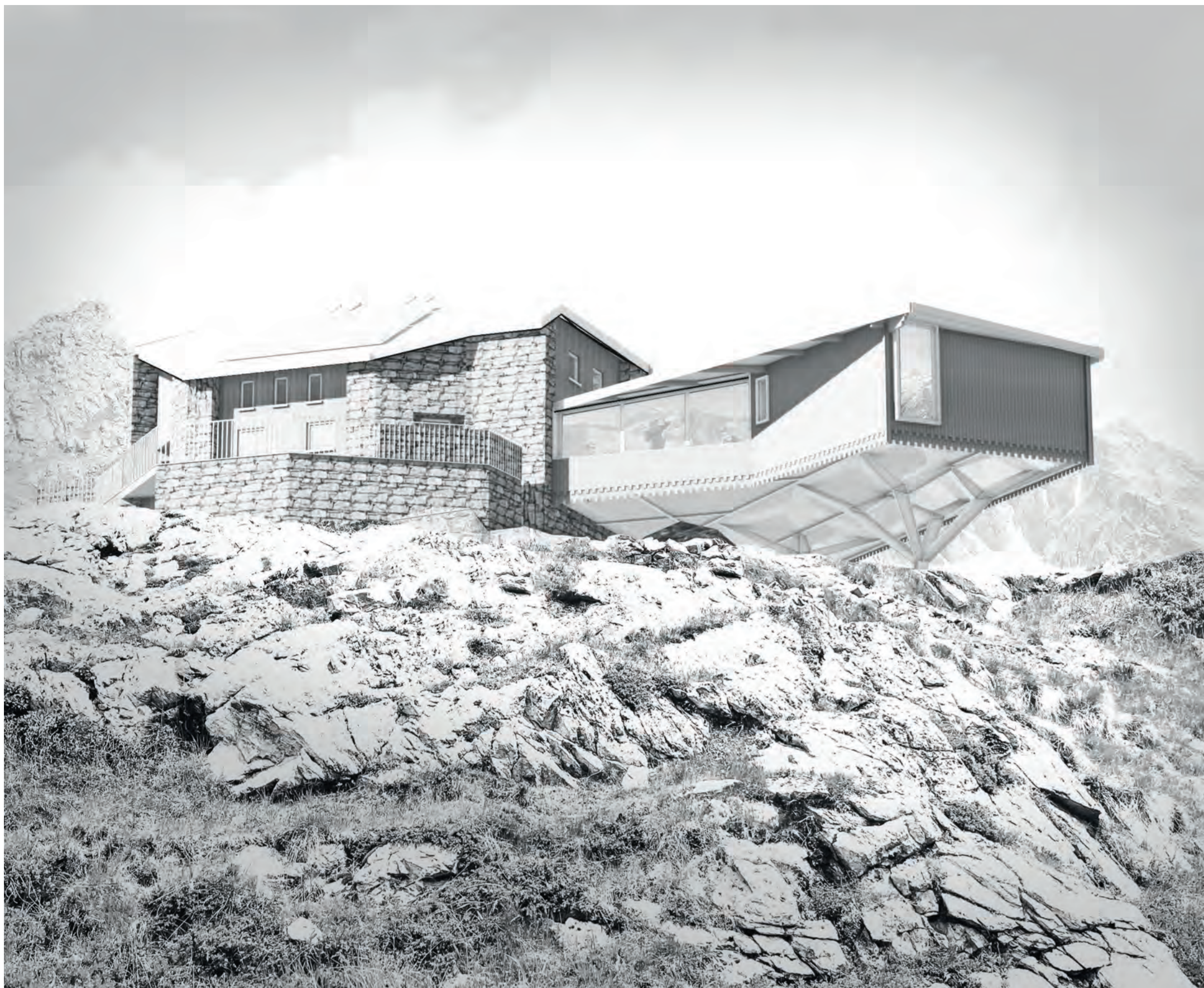
Erweiterung mit baumartigem Tragwerk aus der Untersicht
