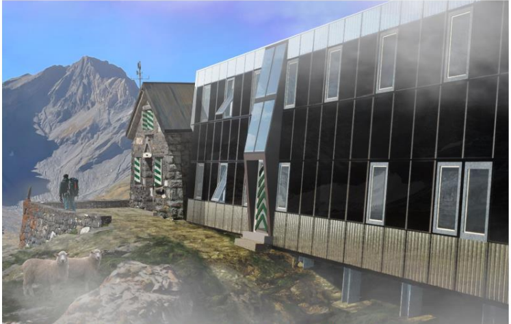
Le nouveau bâtiment vient s'ajouter comme l'ancienne cabane. La façade sud-est est revêtue de panneaux solaires thermiques et photovoltaïques, et des panneaux métalliques de paravent complètent la composition.
