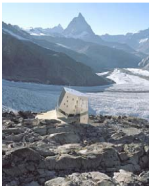
4 Neue Monte-Rosa-Hütte SAC, Blick von Südost mit Matterhorn
