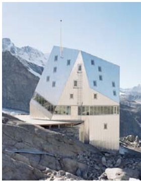
1 Neue Monte-Rosa-Hütte SAC, Ostfassade
