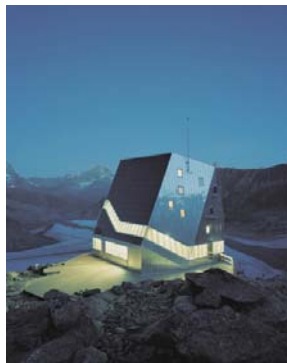
5 Neue Monte-Rosa-Hütte SAC, Südostansicht in der Morgendämmerung
