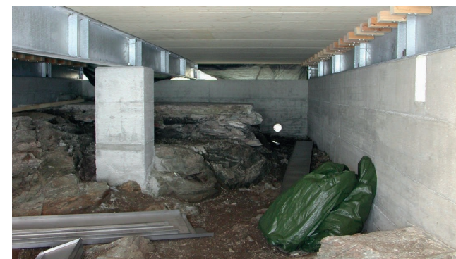
Sous-sol aménagé de manière rudimentaire à la Topalihütte
