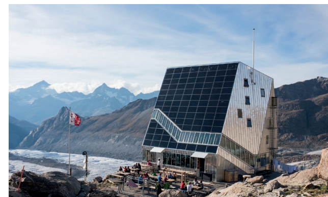
Monte-Rosa-Hütte, 125 couchettes, 2 795 m Nouvelle construction: volume polygonal sur cinq étages.
