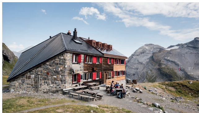
Lämmerenhütte, 96 couchettes, 2 501 m © davidschweizer.ch Transformation et extension avec intégration: forme et conception de l'agrandissement s'inspirent de la cabane existante. A la Lämmerenhütte l'angle massif au dos de l'ancien bâtiment protège aussi des avalanches l'agrandissement ajouté à l'avant.
