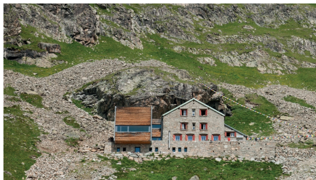
Chamanna da Tschierva, 100 couchettes, 2 583 m 3 © Zettel/Schulthess Transformation et agrandissement avec contraste: les différentes étapes de construction sont clairement mises en valeur.
