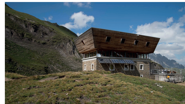
Capanna Corno-Gries, 50 couchettes, 2 338 m 3 © Zettel/Schulthess Transformation et agrandissement avec contraste: surélévation expressive du rez-de-chaussée existant.
